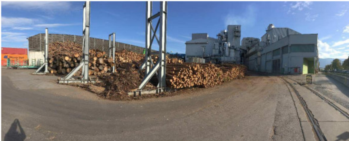
Abb. 8: Panoramaaufnahme des Holzlagerplatzes auf dem Werksgelände auf dem die KWK-Anlage errichtet werden soll (Quelle: Luxplan S.A. 2022).
