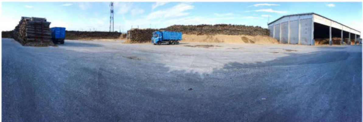
Abb. 7: Panoramaaufnahme des heutigen Holzlagerplatzes auf dem die neue Brennstoffannahmehalle und die Hochsilos entstehen sollen. Die bestehende Holzlagerhalle ist am rechten Bildrand zu erkennen (Quelle: Luxplan S.A. 2022).
